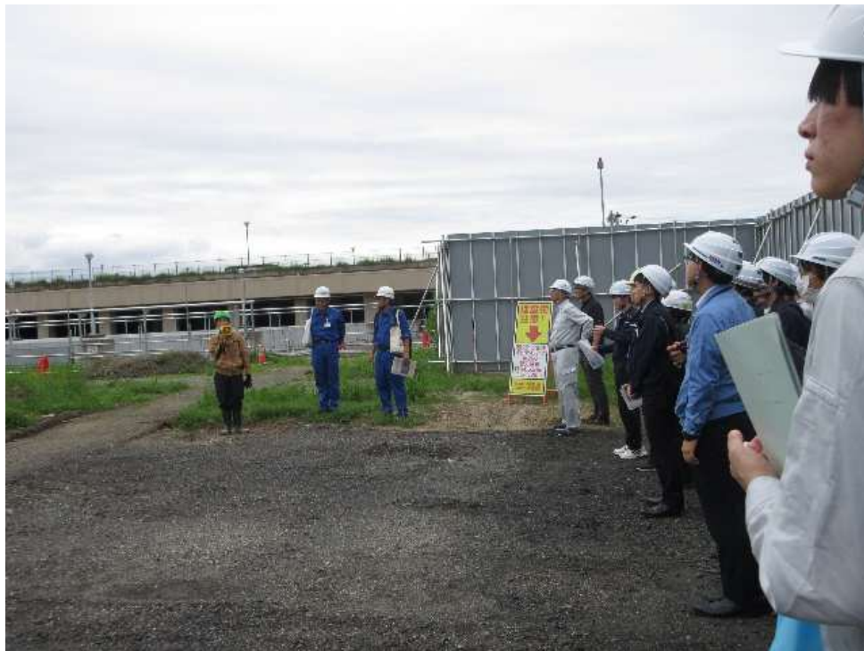
水処理施設増設工事現場
