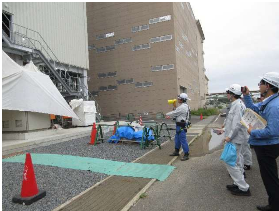
下水汚泥燃料化施設建設工事現場
