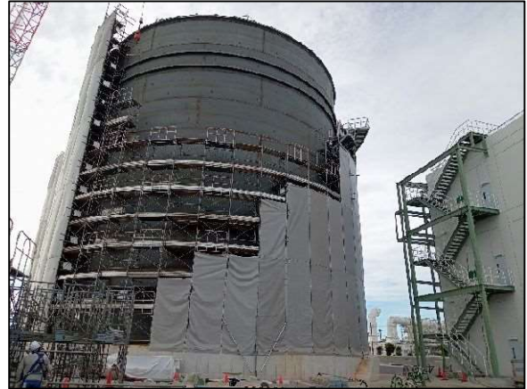
鋼板製消化タンク工事現場
