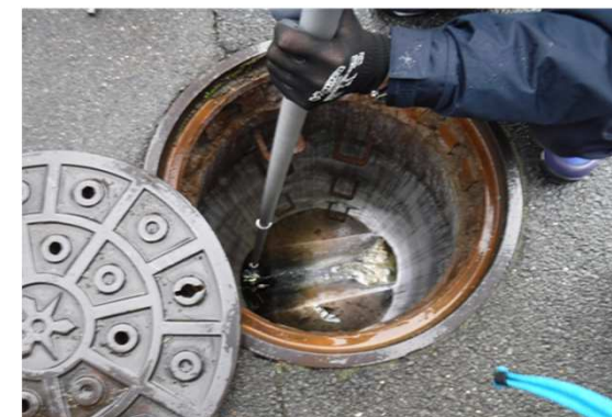
地上からの調査点検の様子
